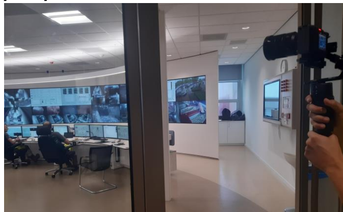
Zdjęcie 38. Zakład termicznego przetwarzania odpadów HVC [2023 r.]
