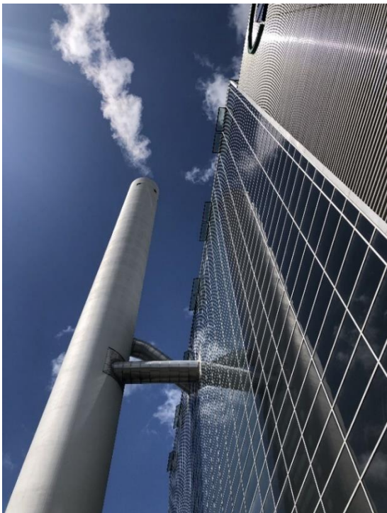
Zdjęcia 3-4. Zakład termicznego przetwarzania odpadów SYSAV [2023 r.]
