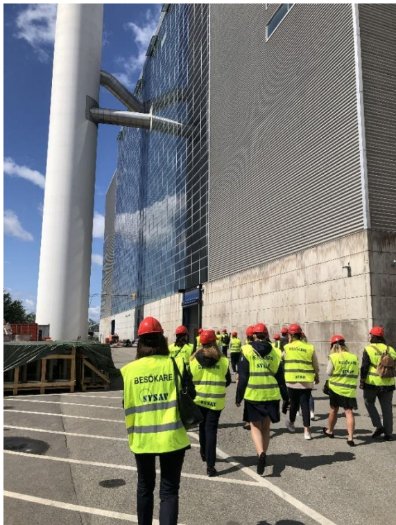
Zdjęcia 8-11. Zakład termicznego przetwarzania odpadów SYSAV [2023 r.]
