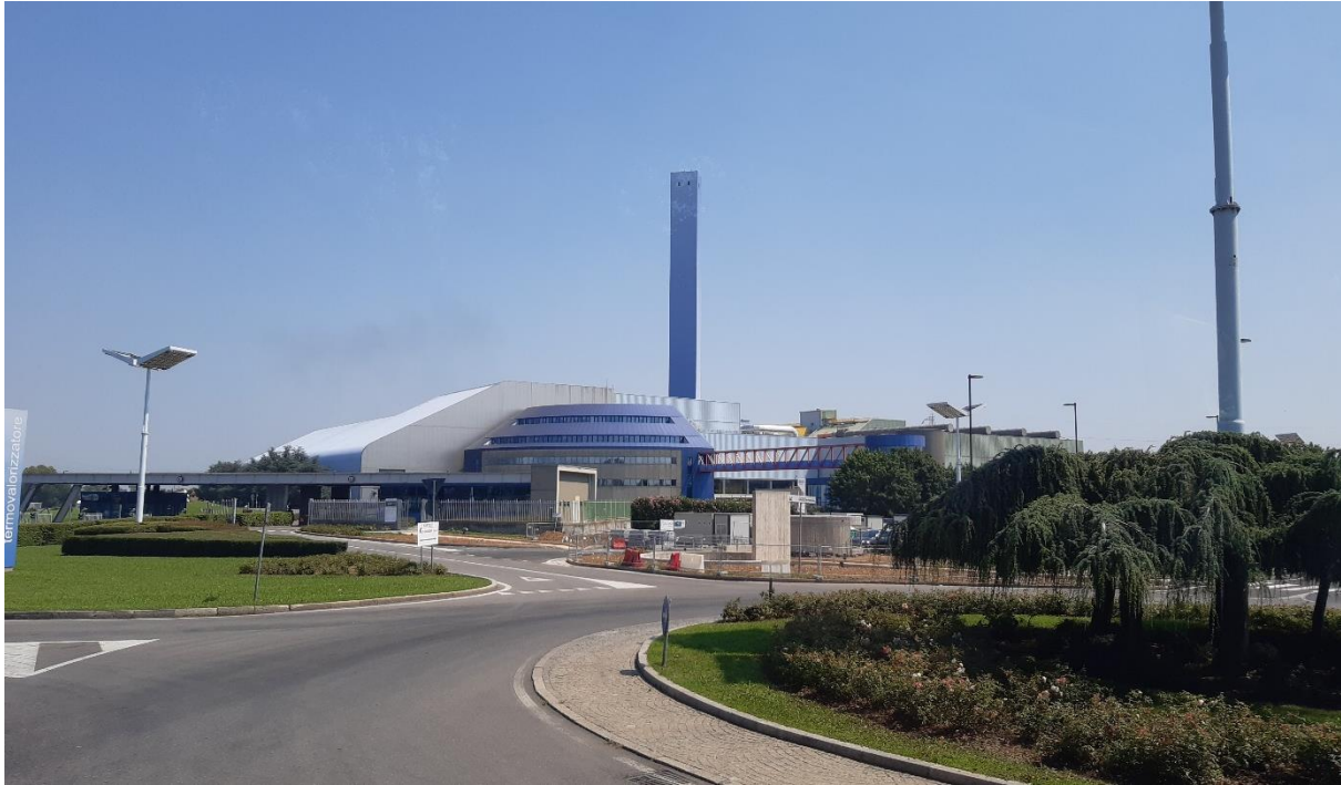
Zdjęcie 28. Zakład termicznego przetwarzania odpadów A2A [2023 r.]
